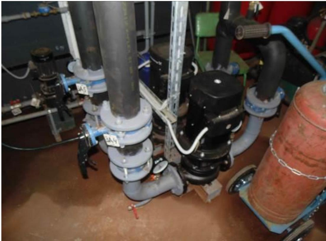
**Рисунок 2.1.2.6 - Насосное оборудование котельной 1,0 МВт**
