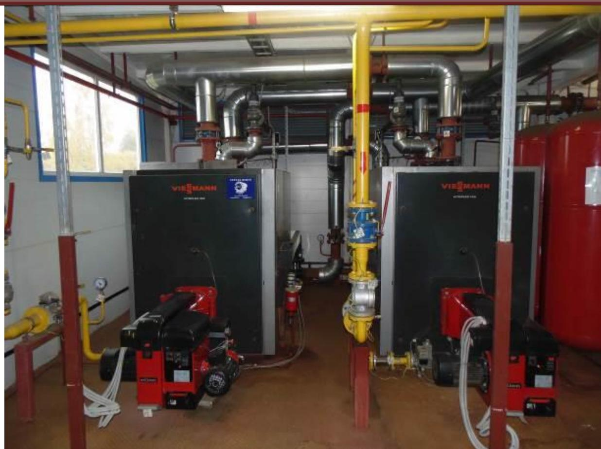
**Рисунок 2.1.2.2 - Котловое оборудование котельной 2,7 МВт**
