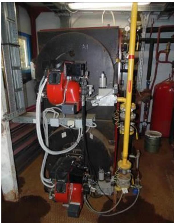
**Рисунок 2.1.2.8 - Котловое оборудование котельной 0,5 МВт**
