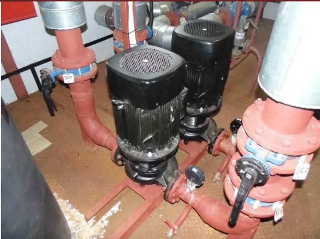
**Рисунок 2.1.2.3 - Насосное оборудование котельной 2,7 МВт**
