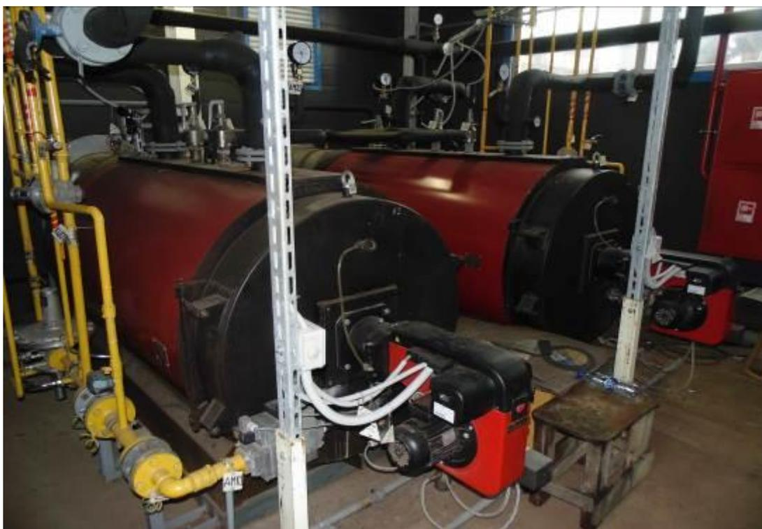
**Рисунок 2.1.2.5 - Котловое оборудование котельной 1 МВт**
